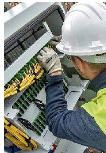
Un operaio installa la fibra ottica: Ravenna ha una buona copertura
